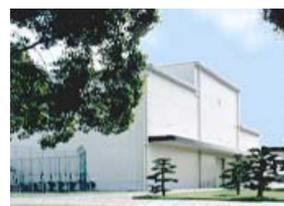
建物は窓をなくし外光を遮った無窓工場で空調により恒温・恒湿化された最新工場
